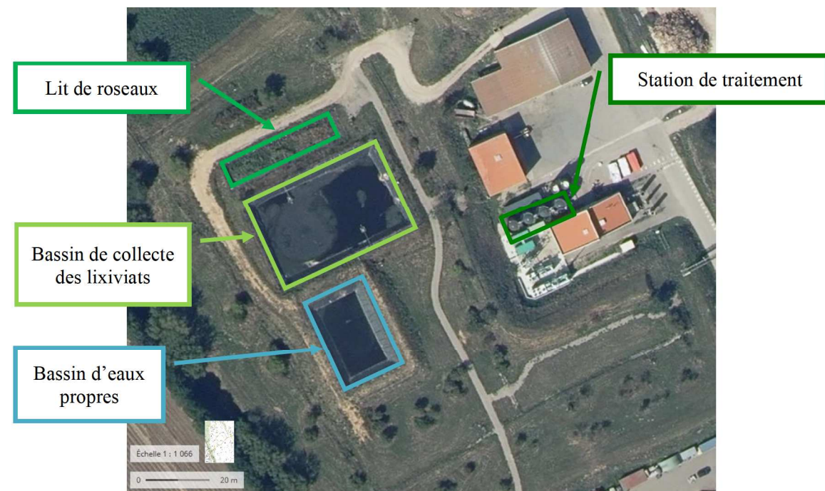
Illustration n° 4 : Installation de traitement des lixiviats (Source : Géoportail)
